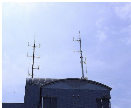
《鋼管柱アンテナ》
